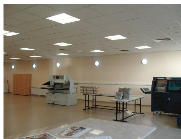
Фиг. 2. Осветителна уредба на основно помещение на Печатна база
