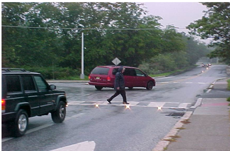
Фиг. 5. Монтирани в настилка светлинни сигнализатори по протежение на пешеходната пътека
