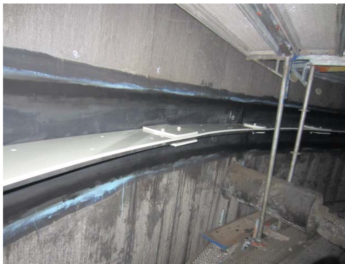
Фиг.3. Стенни пръстени - конзола от стенни пръстени с монтирани чрез болтове полипропиленови предпазни планки
